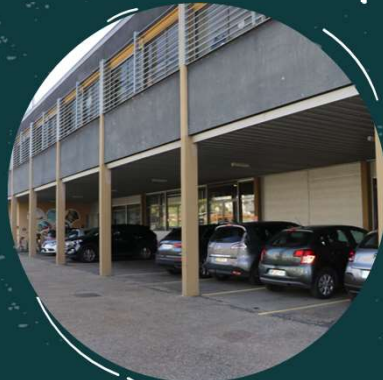
INSTALLATION DANS LES NOUVEAUX LOCAUX
